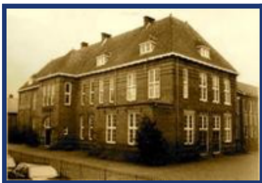
(Het voormalige schoolgebouw, afgebroken in 1983)
